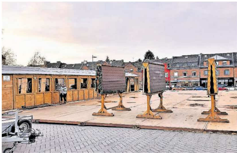
Vorbereitungen für die Winterfreuden: Auf dem Marktplatz in Brand wird derzeit wieder die Schlittschuhbahn mit einem angegliederten Gastrobereich aufgebaut.
